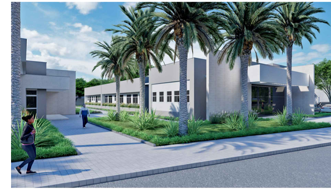
Fachada da UBS
